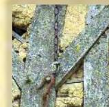
**assemblages de biais**, reliant les liens et les écharpes nécessaires à la stabilité des constructions, aux poteaux, colombes et sablières
