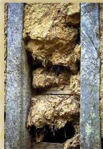
Mélange de terre (limon argileux), de foin et d'eau, malaxé au pied ou par des animaux, ce matériau mis en œuvre en faible épaisseur, est non-porteur. Il nécessite une structure d'accroche pour le maintenir entre les pans de bois.
