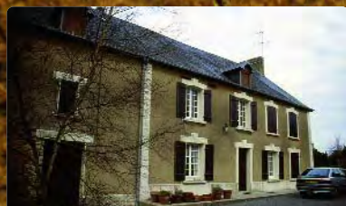
Dénaturation de l'aspect originel du bâtiment
