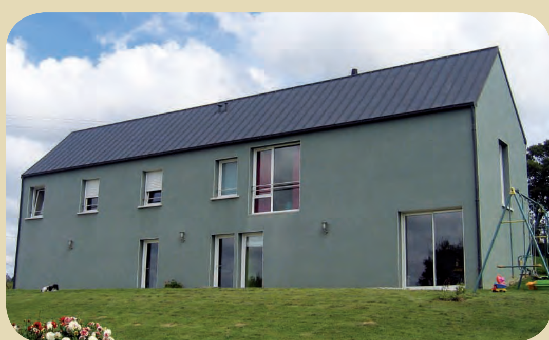
Habitat individuel - Y. Lejeune architecte - Bricquebec
