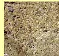
Le matériau communément employé dans le Nord du département, appelé "**mâsse**", est un mélange de terre argileuse et de fibres végétales, utilisé sans ossature, sous forme de parois de forte épaisseur. Ces murs reposent toujours sur un **soubassement en pierre** qui limite les remontées d'humidité, empêchant la terre de se déliter.
