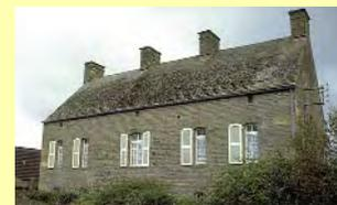
Les souches de cheminées sont systématiquement implantées dans l'axe du faîtage, à même les pignons ou sur les murs de refend. Elles sont souvent de facture soignée. L'usage de pierre de taille est fréquent, même sur les édifices modestes, afin d'assurer la pérennité de l'ouvrage.
