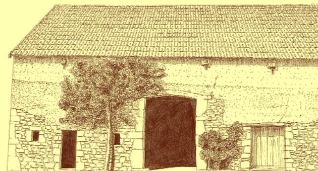
Les murs reposent toujours sur un soubassement en pierre qui limite les remontées d'humidité, empêchant la terre de se déliter.
